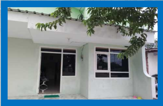
TAMPAK DEPAN RUANG KANTOR UNTUK KEGIATAN ADMINISTRASI GUDANG
